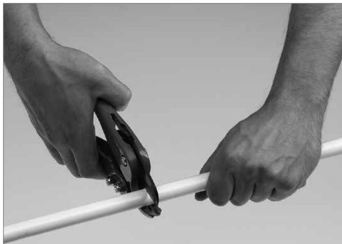
Отрезать трубу с помощью труборезных ножниц (арт. 7 200 93) под прямым углом.
