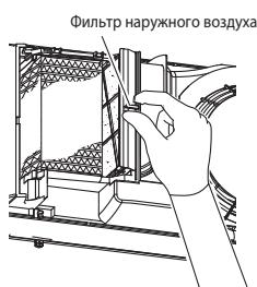
Фильтр наружного воздуха можно почистить пылесосом и прополоскать в теплой воде (температура не более 40°C) с нейтральным моющим средством. После 4 таких операций рекомендуется заменить фильтр (опция Р-50F2-E).
